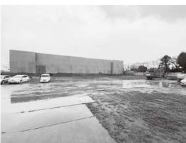
▲解体工事中の旧小川小学校
