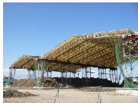
可燃物の貯留ヤード (宮城県石巻市、平成 25 年 6 月)
