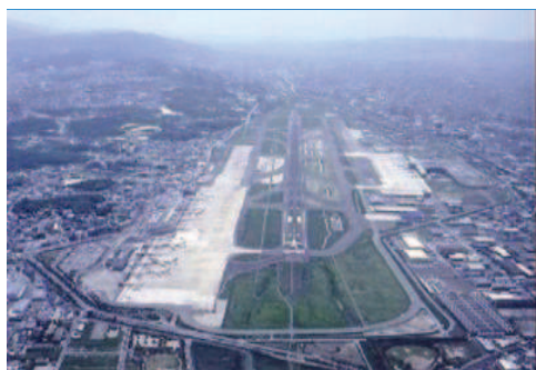
①上空から見た福岡空港
