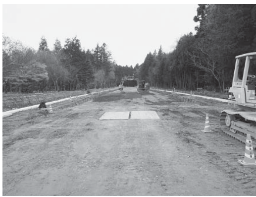
道路整備事業用地 (納場地内)
