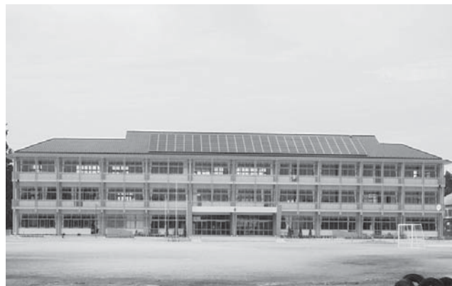
太陽光発電設備が設置された竹原小学校新校舎
