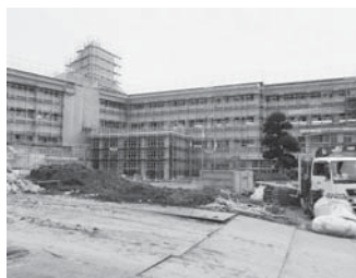
小川南中学校が移転する旧小川高校
