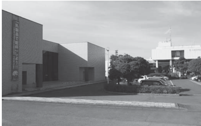
一括して耐震診断を発注する公共施設(美野里公民館と市役所本庁舎)
