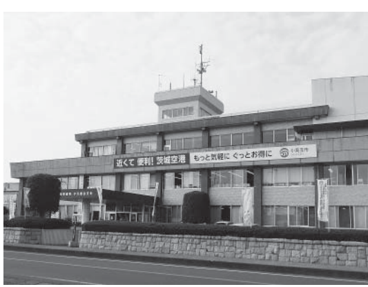
耐震工事が行われる小川総合支所
