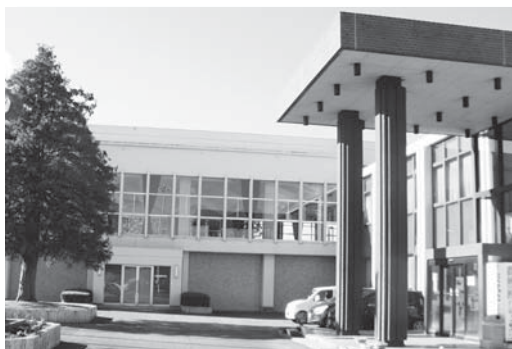
既存の体育館等の耐震化が進んでいる（農村環境改善センター）
