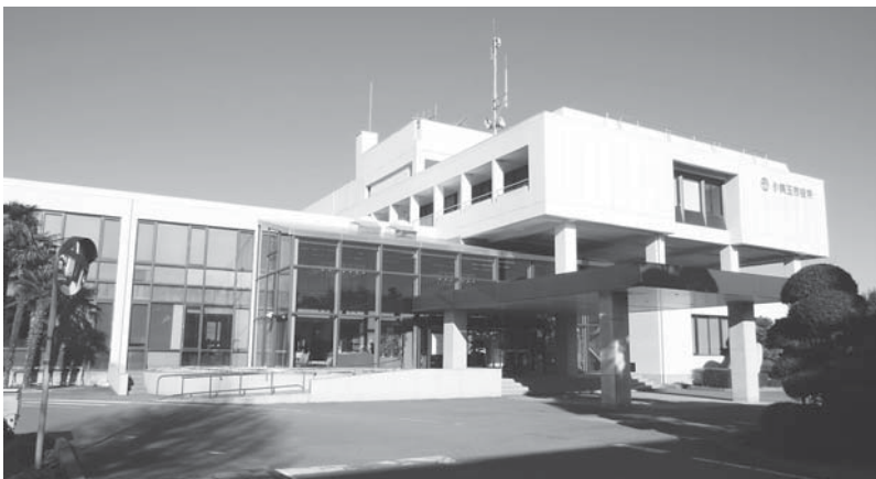
本年度に耐震化改修工事設計が予定されている本庁舎
