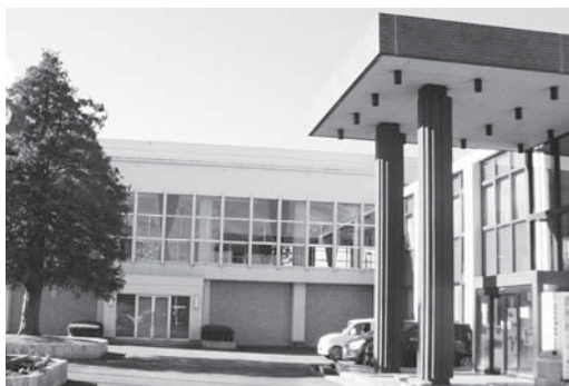
既存の体育館等の耐震化が進んでいる (農村環境改善センター)
