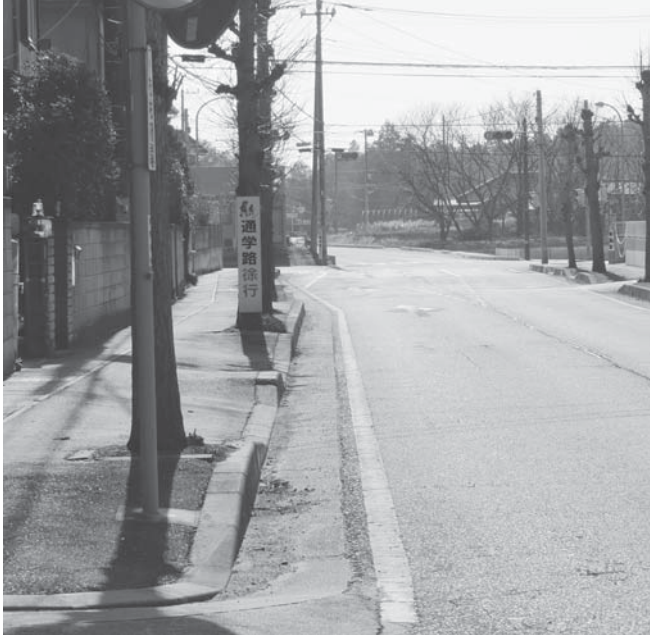
マウントアップ型歩道（脇山地区 イチョウ通り）
