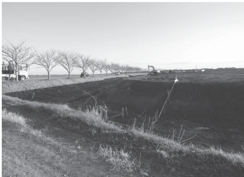
(仮称) 大井戸湖岸公園整備工事に着手
