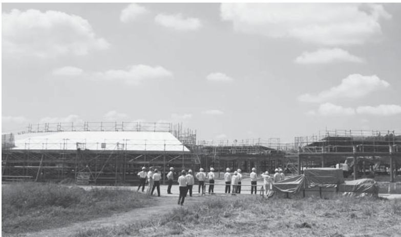
茨城空港近くに急ピッチで建設が進む（仮称）「空の駅」
