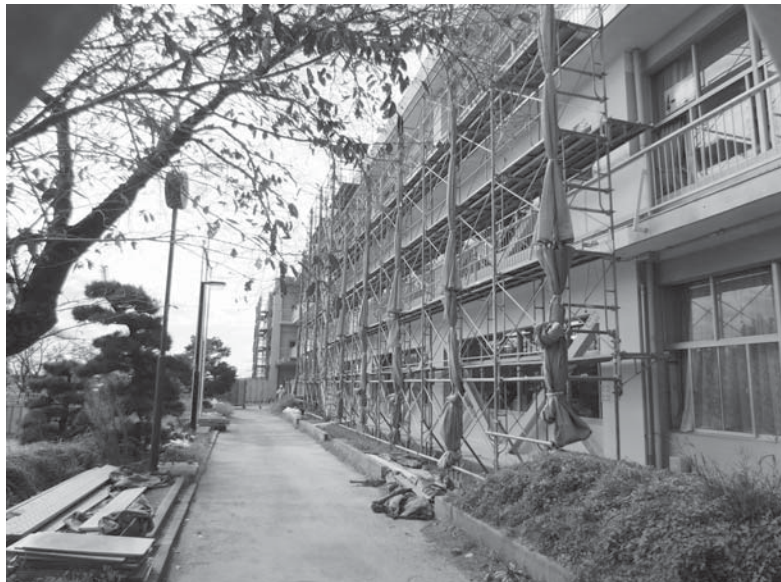
耐震補強工事を実施している校舎（エアコン未整備）
