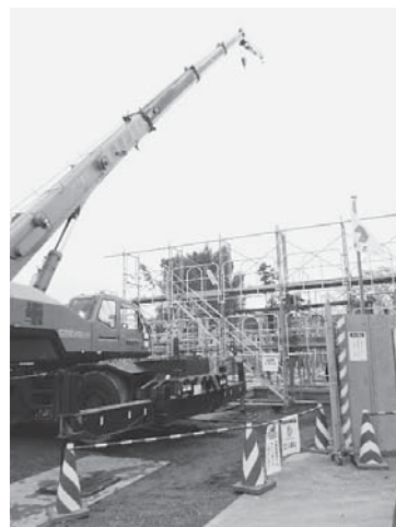
1月開設に向け急ピッチで建設中(羽鳥小、学童施設)
