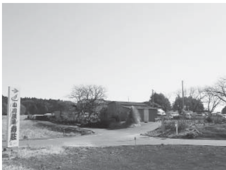
老朽化した本館等の建築工事が間もなく始められる「小川温泉寿荘」。その財源として再編交付金が活用される
