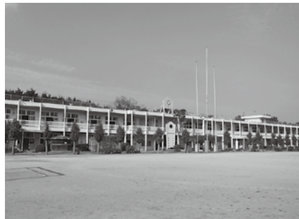
建て替えによる耐震化を実施するためのスケジュール調整など具体的な準備が進められる堅倉小学校
