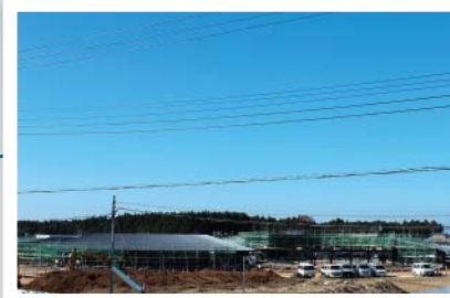
2013.11.23 工事現場の様子
